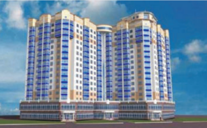
Stadt Sergiev Posad, Gebiet Severny 4 Wohnhäuser
